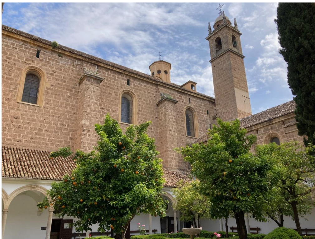
Fig. 5. Cristóbal de Vilches e hijos. Iglesia de la cartuja de Granada , muro perimetral sur. © Foto del autor
