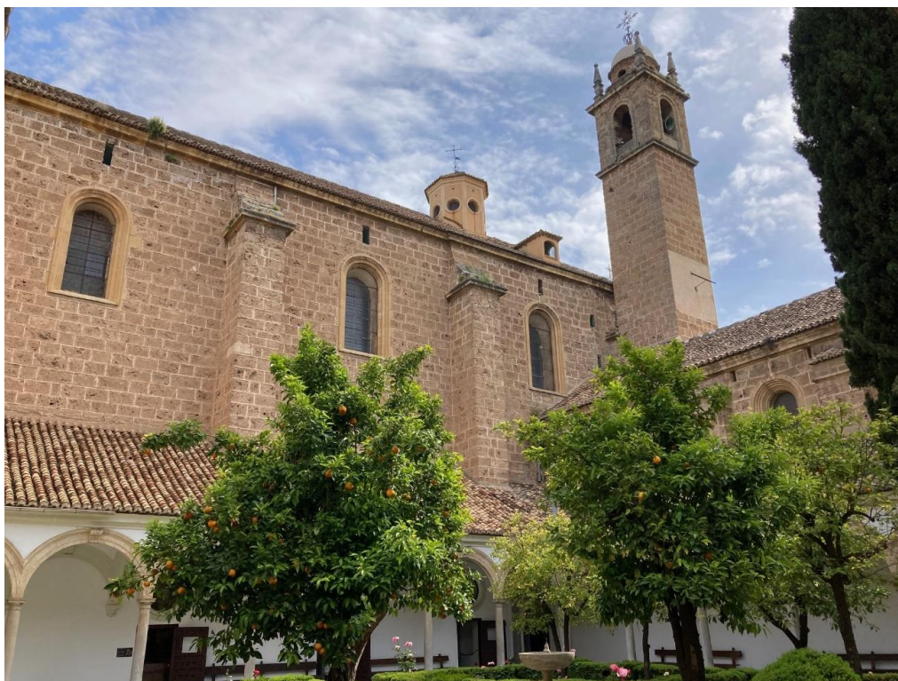
Fig. 5. Cristóbal de Vilches e hijos. Iglesia de la cartuja de Granada , muro perimetral sur. © Foto del autor
